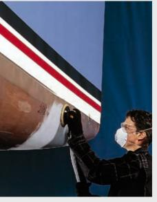
wird die Lunge eines Arbeiters einer viel geringeren Menge Staub ausgesetzt. Mit einer guten Staubabsaugung können auch Spezialmetalle wie Zink und Aluminium, sowie Verbundwerkstoffe wie Kohlefaser und Glasfaser geschliffen werden.
